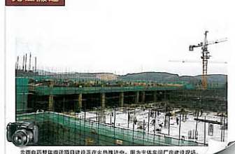
云南白药集团总部迁址建设在火热进行中，图为全体车间厂房建设现场。
