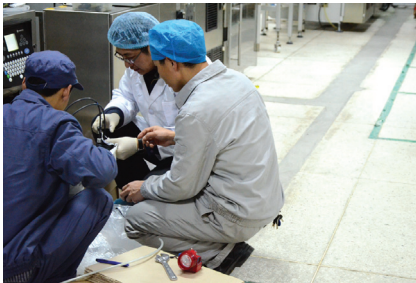
设备检修现场
